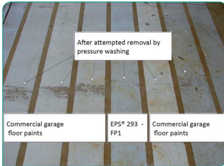
Fig. 6 EPS® 293 – FP1 dopo la pulitura con getto d'acqua ad alta pressione EPS® 293 - FP1 after high pressure water jet cleaning
